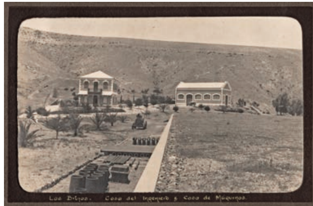
Las Brujas. Instalaciones de la City of Las Palmas Water Power Co. Ltd., ca. 1930.
