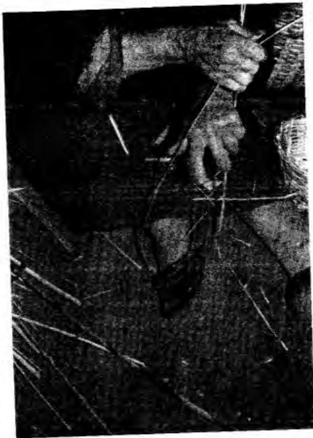
FIG. 11.—Pasando por el pie la "estilla del remache". A la derecha se aprecia parte de la cesta con las puntas viradas y un asa preparada
