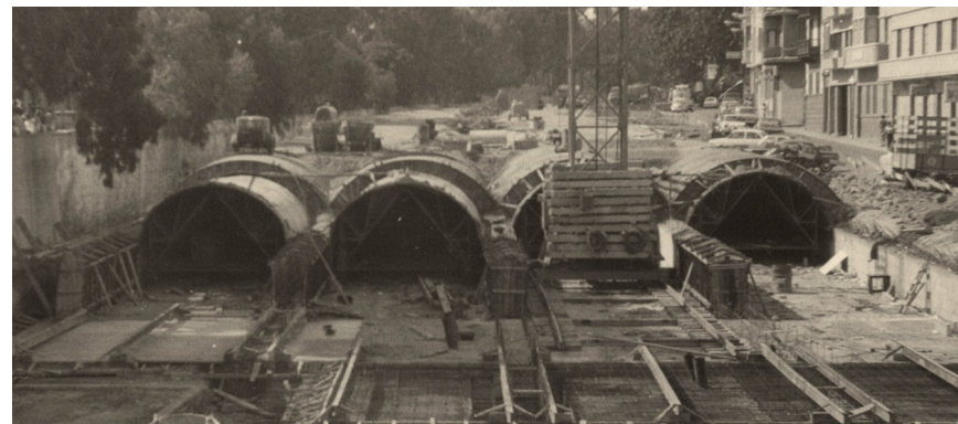
Canalización del barranco Guinguada (1970)
