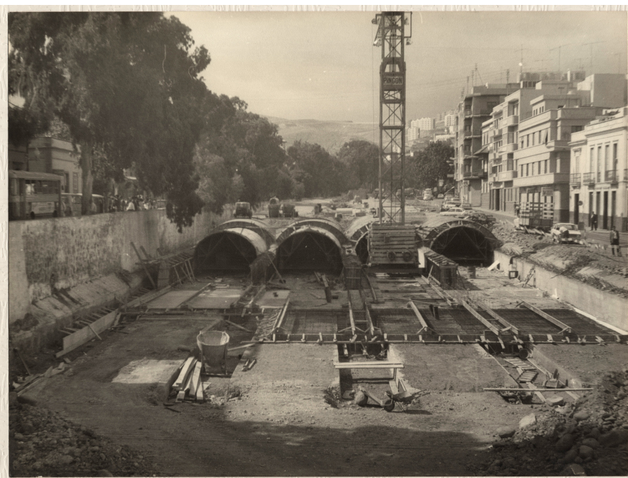
Construcción de la carretera de acceso a Las Palmas de Gran Canaria por el centro (1970). Colección documental Álvaro Talavera Herrera [ES 35001 AMC-AT 021]
