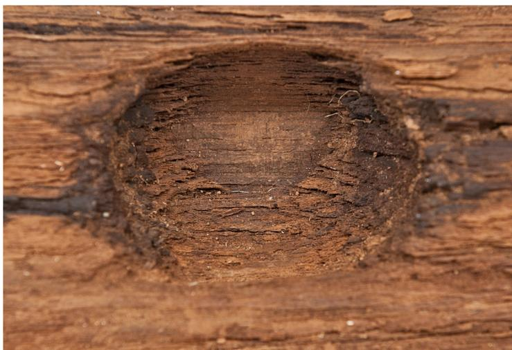
Detalle del orificio destinado a recibir un pasador para el cerramiento o bloqueo de la puerta.
