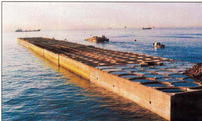
pista. Llenando sus pozos de agua, la cajonera se hunde lo suficiente como para descansar sobre su emplazamiento definitivo, operación delicadísima que requiere mar en calma y una gran precisión. Luego, el agua de los pozos es reemplazada por tierra y piedras, hasta formar todo un bloque compacto que constituye la base firme del nuevo muelle.
